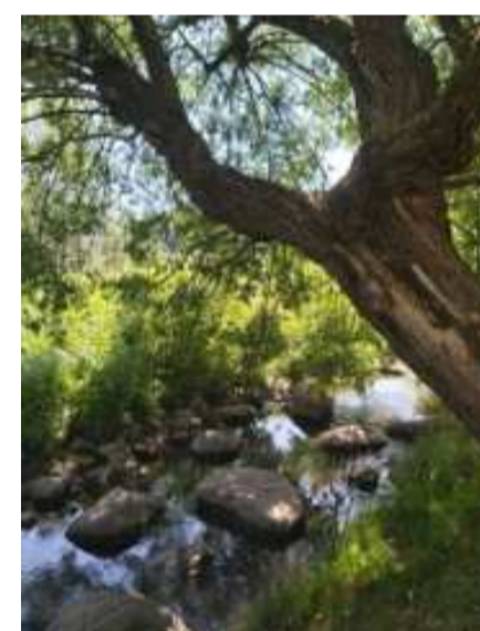
Kuva 1: Uomaan asennetaan kiviä vapaamuotoisesti
